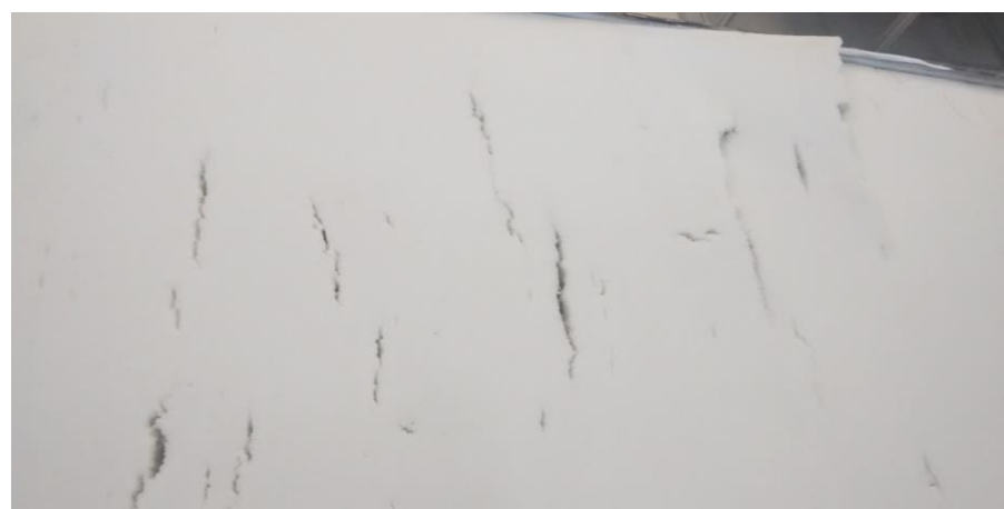
FOTOS 4 À 6 – FALHAS ESTRUTURIAS NAS LAMINAS DE ESPUMA
